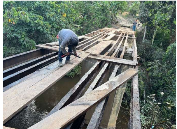
FOTO 4: Limpeza dos perfis metálicos com jato;
