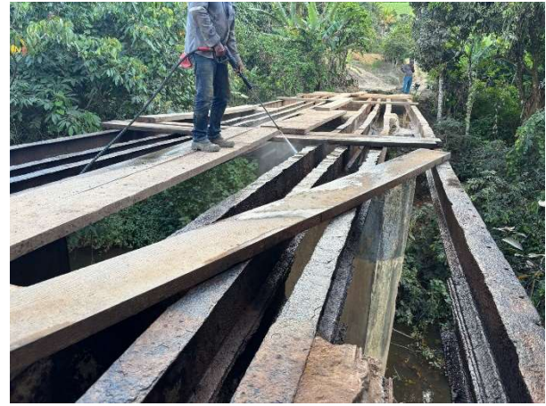
FOTO 2: Limpeza dos perfis metálicos com jato;
