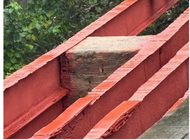
FOTO 8: Pintura com zarcão dos perfis existentes;
