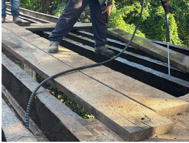
FOTO 1: Limpeza dos perfis metálicos com jato;
