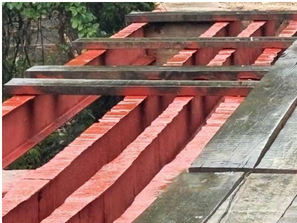
FOTO 9: Pintura com zarcão dos perfis existentes;
