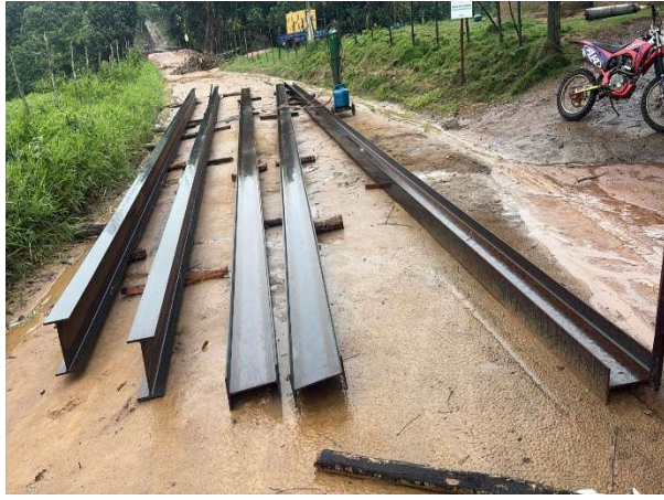
FOTO 7: Perfis de reforço sendo soldados;
