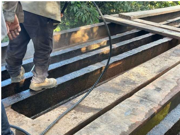
FOTO 3: Limpeza dos perfis metálicos com jato;
