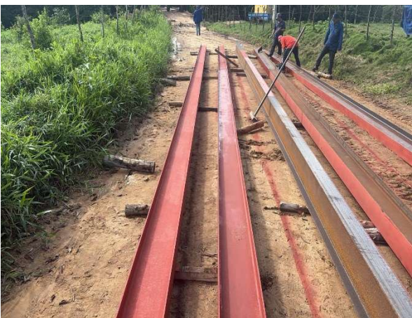
FOTO 11: Pintura com zarcão dos perfis novos;
