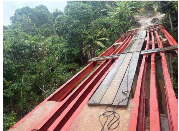
FOTO 10: Pintura com zarcão dos perfis existentes;
