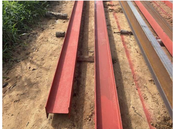
FOTO 12: Pintura com zarcão dos perfis novos;
