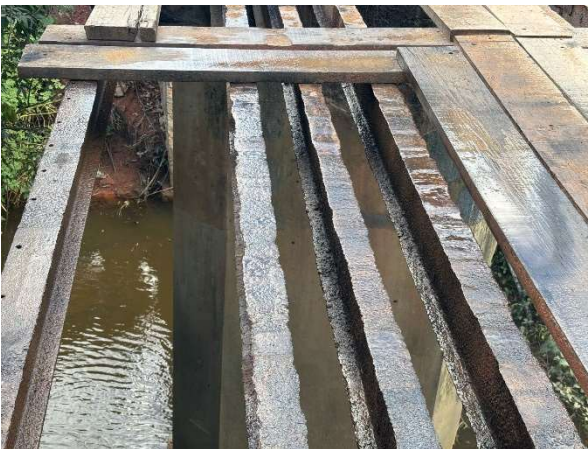
FOTO 5: Limpeza dos perfis metálicos com jato;
